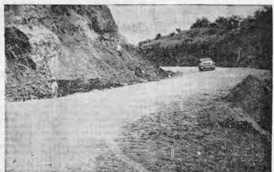
Vista parcial de la carretera debidamente bachada y lasirada que permite un rodaje seguro en todo el trayecto.
