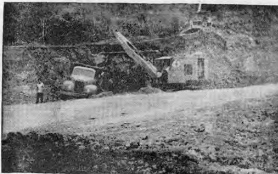
Trabajadores y equipo del Ministerio de Transportes en labor de bachado a lo largo de todo el trayecto San Ramón - Barranca.
