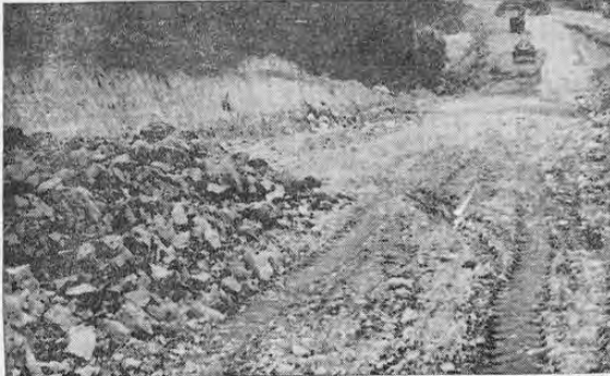
Aspecto de uno de los deslizamientos producidos por los temporales.
