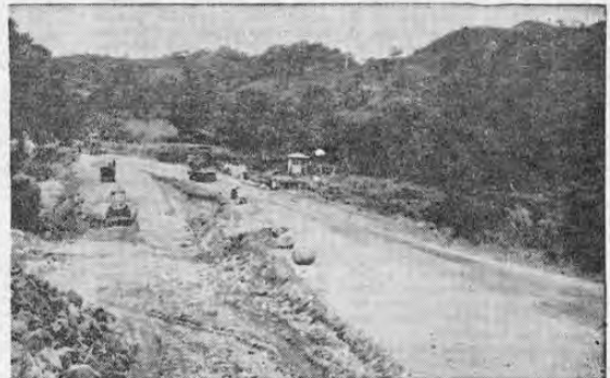
Desvío de 200 metros que permite el tránsito seguro en uno de los deslizamientos.
